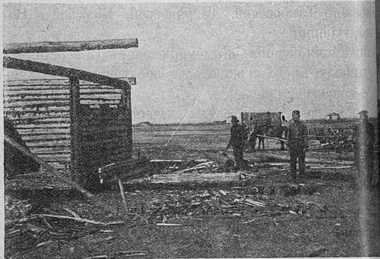
Постройка избы переселенцами.
