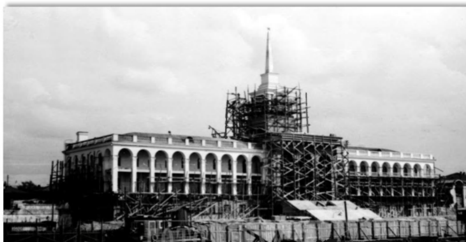
Строительство Речного вокзала в г. Красноярске, 1951 г. [1].
