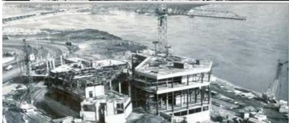
Строительство Музея им. В.И. Ленина в г. Красноярске, 1980-е гг. [4].
