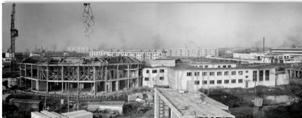
Красноярский цирк в период строительства, 1970 г. [3].
