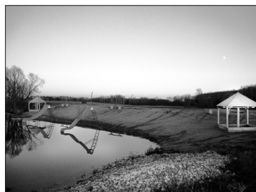
После проведения работ
