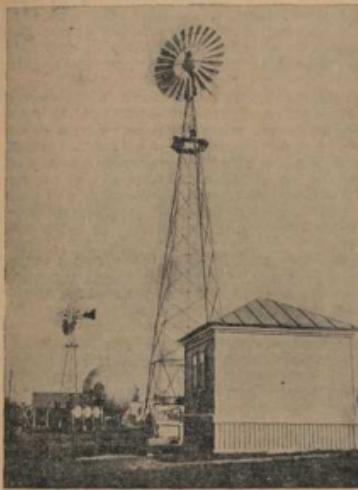
Общий вид тихоходных ветродвигателей, показанных на территории ВСХВ. На переднем плане ветродвигатель ТВ-8. Его мощность — 6 л. с., общий вес с башней 3470 кг. Виден другой тихоходный ветродвигатель ТВ-5. Мощность — 2,5 л. с., вес с башней — 2080 кг
