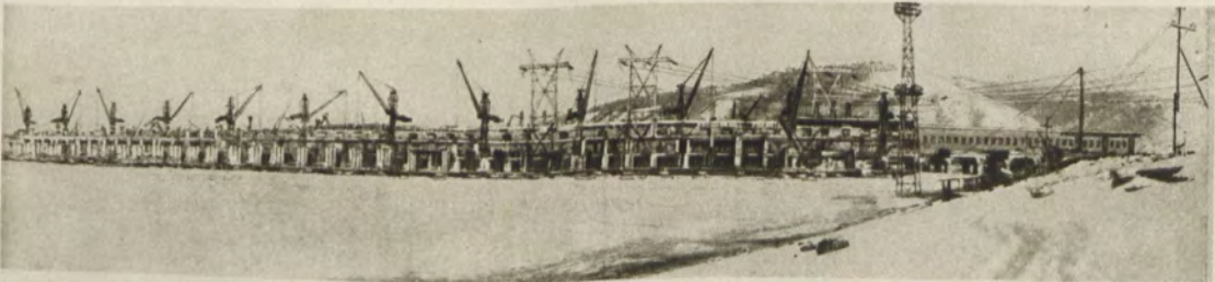
Общий вид плотины с машинным зданием с верхнего бьефа.
