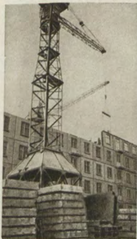
Слева — строительство жилых домов в Запорожье; в центре — монтаж 5-этажного жилого дома из крупных панелей в Ленинграде; справа — строительство школы из крупных блоков в Харькове.
