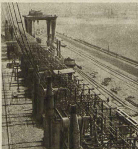
Слева — площадка машинного здания с открытой повысительной трансформаторной подстанцией 13,8/400 кВ; справа — воздушный выключатель напряжением 400 кВ.
