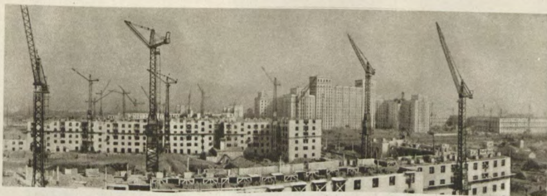
Строительство жилых домов в Юго-западном районе Москвы.
