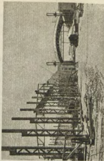
Строительство комбината строительных конструкций и деталей в Ленинграде (монтаж сборного железобетонного каркаса).
