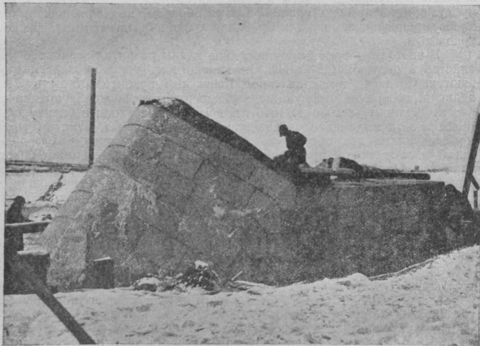
Рис. 10. Бык Иртышского моста во время ледохода.
