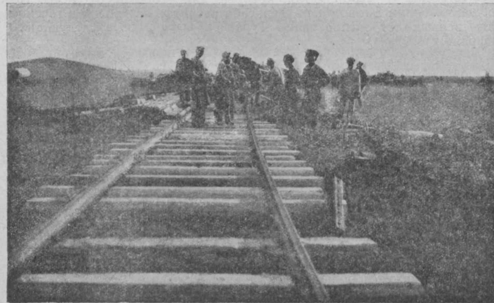
Рис. 11. Укладка пути на 13 км южного участка.
