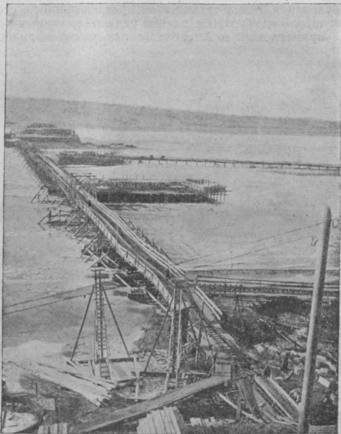
Рис. 8. Сооружение постоянного моста на р. Иртыш (опускание кессонов).
