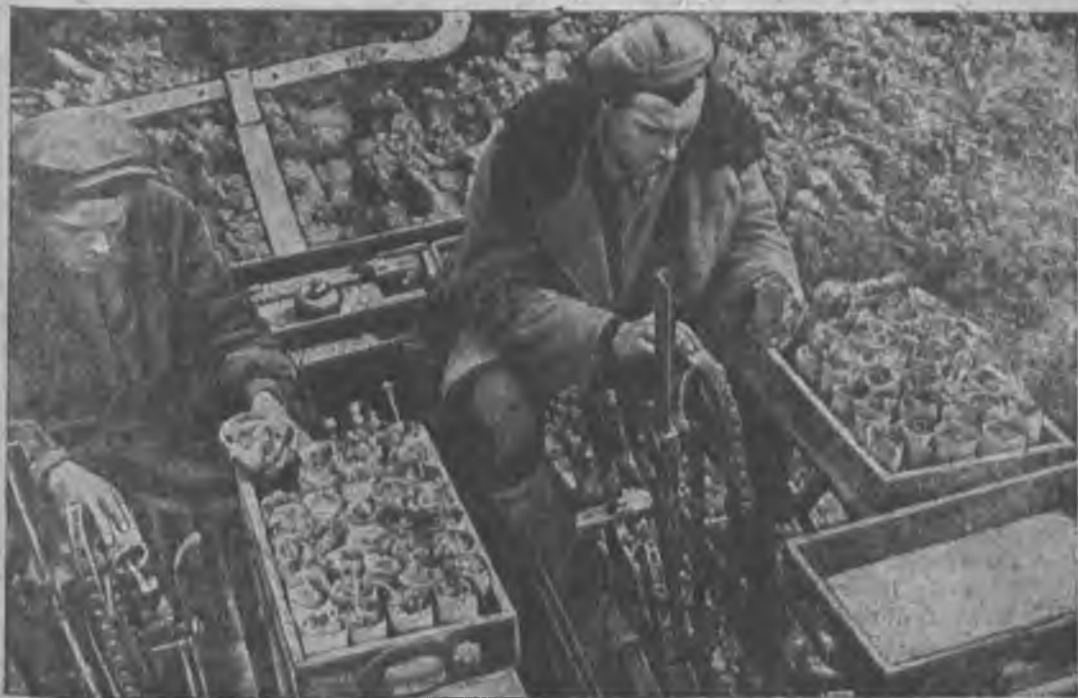
Испытание советской хлопкопосадочной машины ПХ2 на Каунчинской машиноиспытательной станции (Узбекистан, Каунчинский район).
