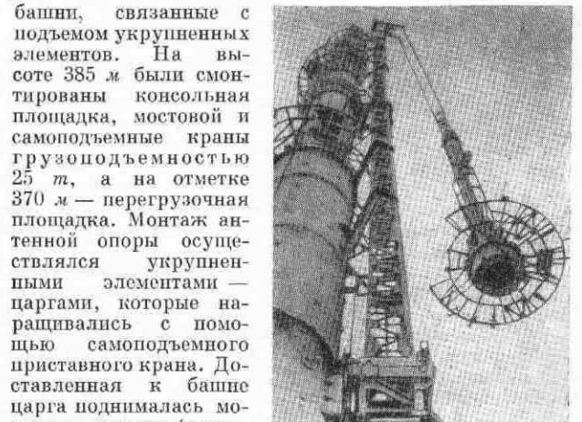
Рис. 5. Монтаж последнего элемента антенны.
