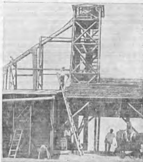
Суворовский элеватор (Минераловодский р-н, Сев. Кавказ) устроил специальную площадку для приемки зерна, привозимого колхозниками в бестарных повозках.
