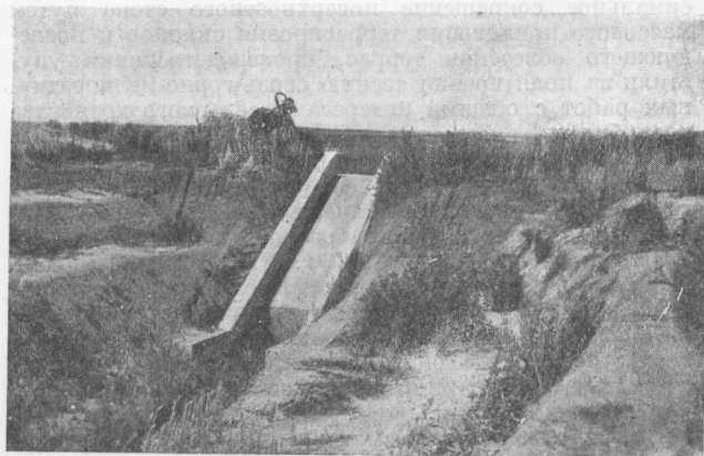
17. Вершинное овраго-укрепительное сооружение (каменно-бетонный быстроток).
